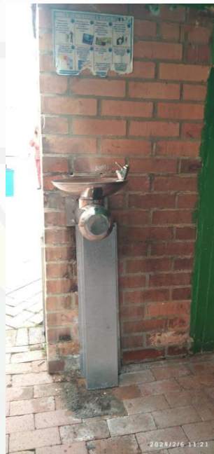
Instalación de bebederos
